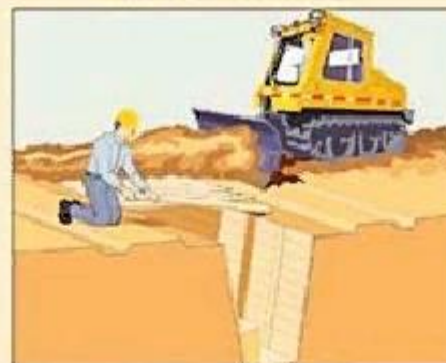
Оборудование перекрытой щели
